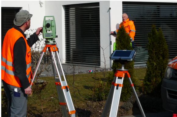
Einmessung der Lage des Gebäudes
