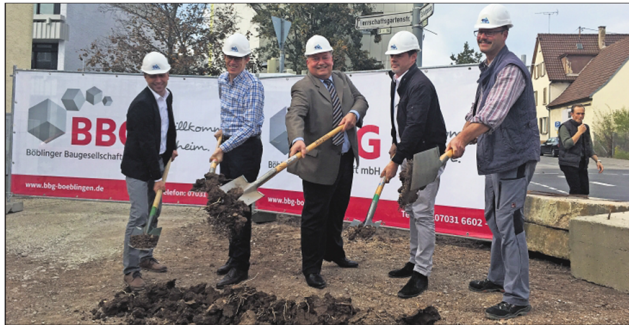
Oberbürgermeister Wolfgang Lützner und BBG-Geschäftsführer Rainer Ganske (2. und 3. von links) gaben den Startschuss für den Bau preisgünstiger Mietwohnungen in der Böblinger Schafgasse. Foto: Kühnle
